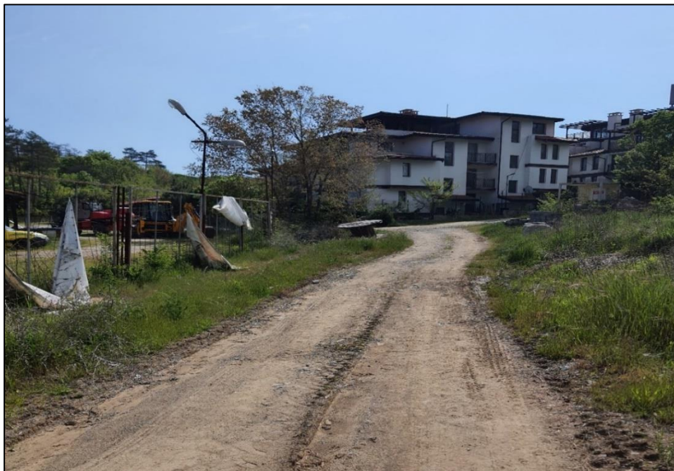
Снимка 2.1.7.2-2 Път граничещ с ПИ № 67800.35.139 (в ляво на снимката), и съществуващите постройки в съседен имот, част от ВС „Санта Марина“
